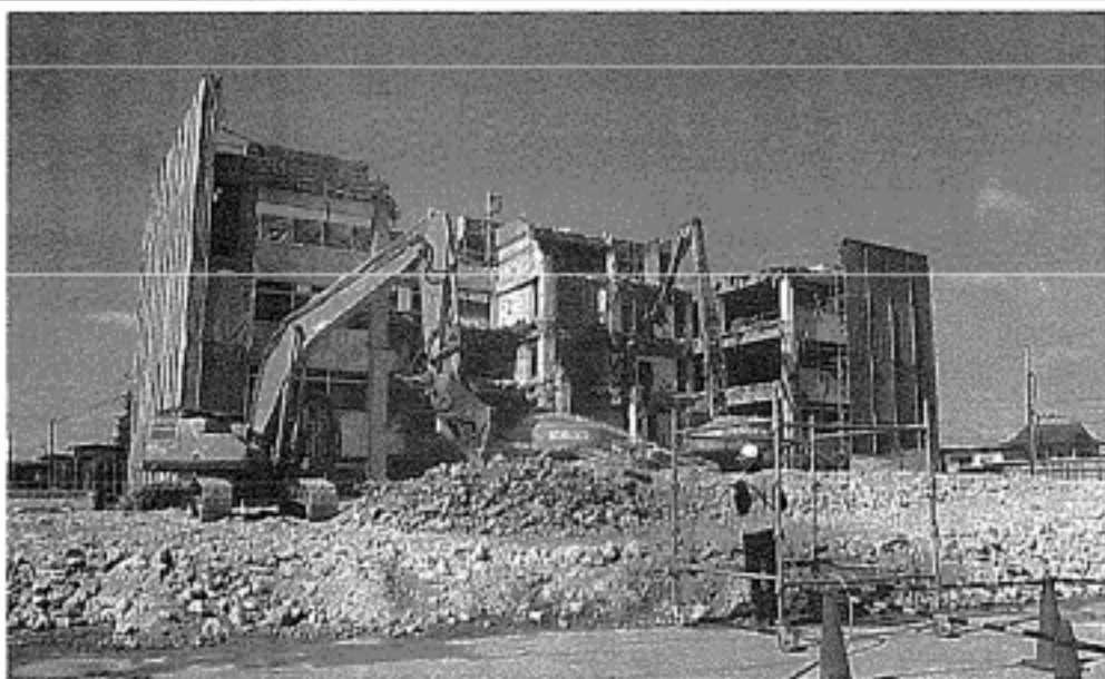
解体が進む旧市役所西庁舎
