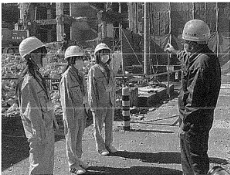
解体作業について説明を受ける生徒たち
