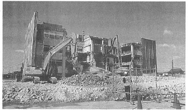
解体が進む旧市役所西庁舎
