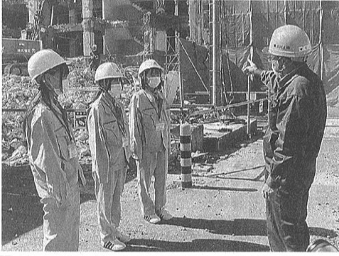
解体作業について説明を受ける生徒たち
