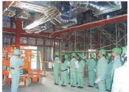
上/古川工業高等学校建築科の現場実習時の 集合写真(大崎南給食センター) 下/鉄骨 造の現場内部で構造・設備等を見学実習
