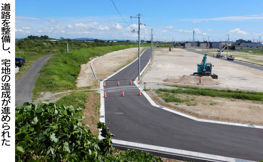
江戸川堤防上から見た工事中の区画整理地区
