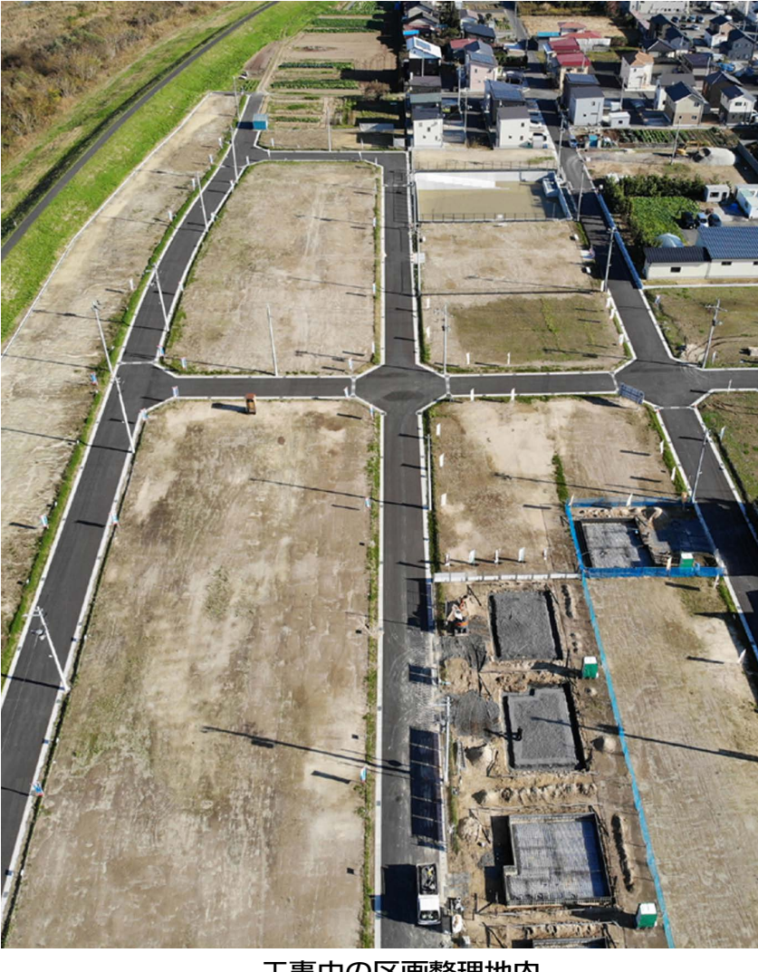
工事中の区画整理地内
