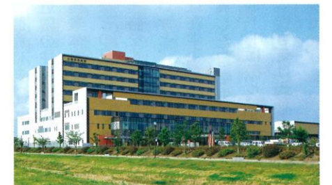
建設事業部が共同企業体（JV）により元請けとして携わった大崎市民病院本院
