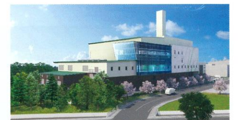
西地区熱回収施設整備・運営事業（JV） 2022年4月運営開始
