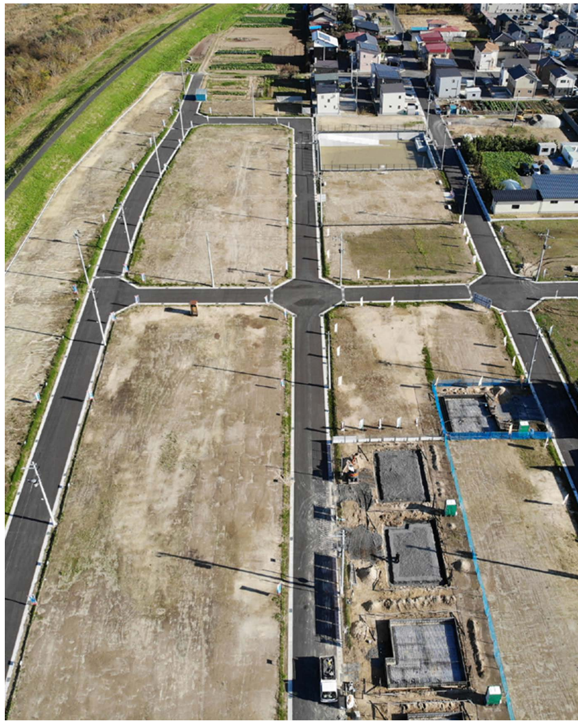
工事中の区画整理地内
