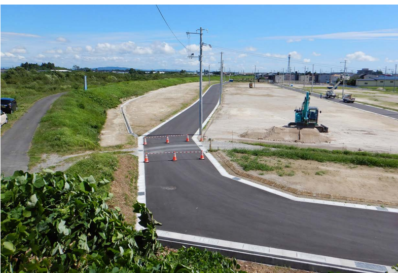
道路を整備し、宅地の造成が進められた
