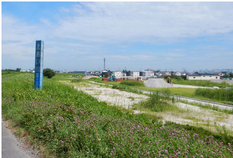
江合川堤防上から見た工事中の区画整理地区
