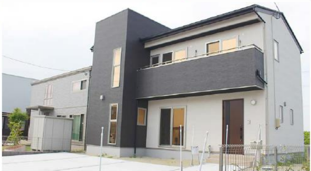
宅地に生まれ変わった区画整理地内では、住宅の建築が進んでいる
